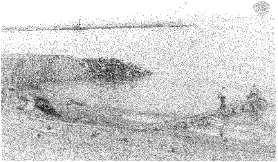
Construcción del dique de poniente en el puerto pesquero de Estepona.
