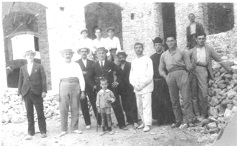
Esta foto corresponde a la construcción del Grupo escolar Simón Fernández. Empezó a construirse en 1.915 y se terminó en 1.923. En primer término, el gran maestro albañil D. Pedro Gil, junto con el alcalde D. Simón Fernández.
