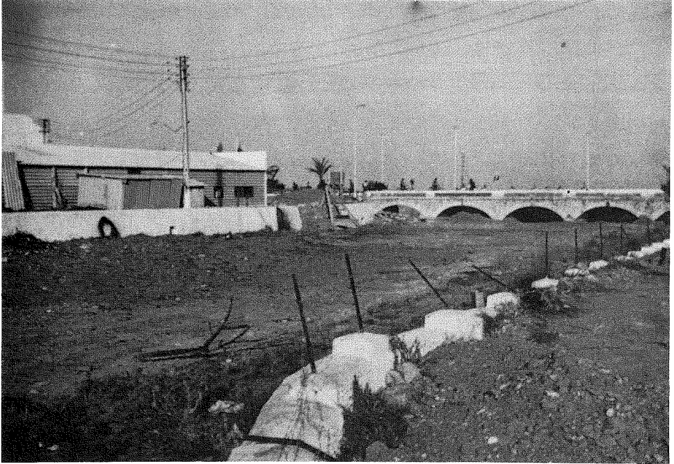
Desembocadura del río Monterroso antes de su embovedado
