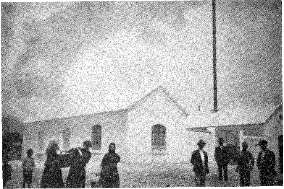
Antigua fábrica de la luz San Lorenzo. Esta fábrica funcionó con carbón mineral
