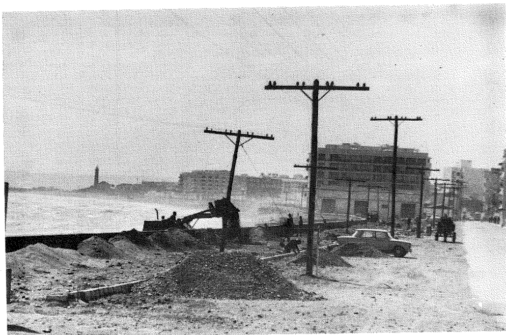
Construcción del Paseo Marítimo por la zona de levante
