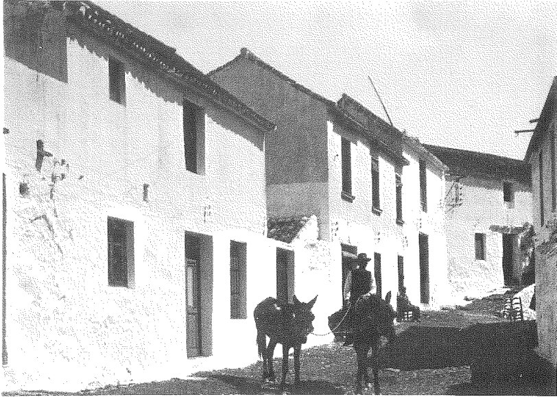
Calle típica esteponera antes de su asfaltado y arreglo
