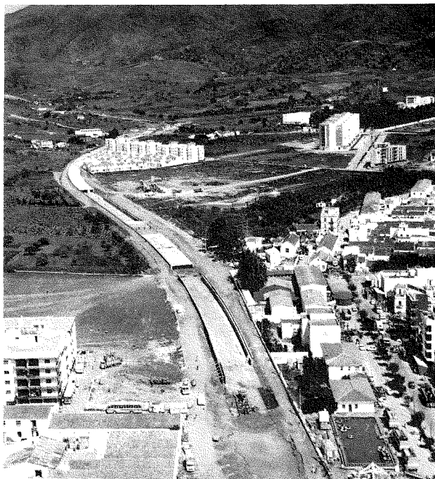
Construcción del embovedado del Monterroso
