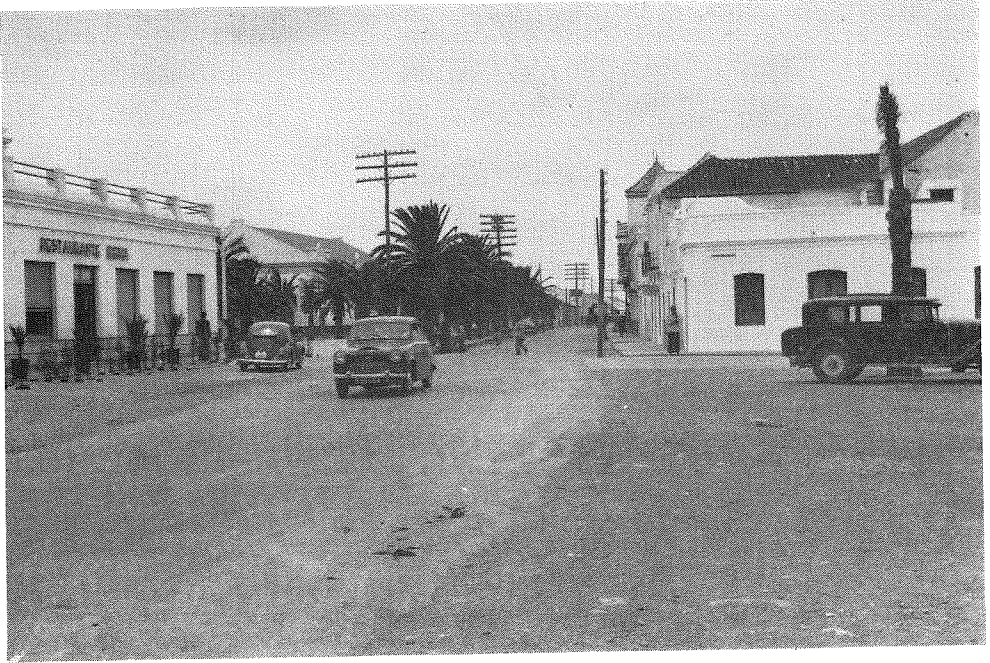
Carretera General Cádiz-Málaga a su paso por Estepona. Al fondo, el Paseo del Carmen.
