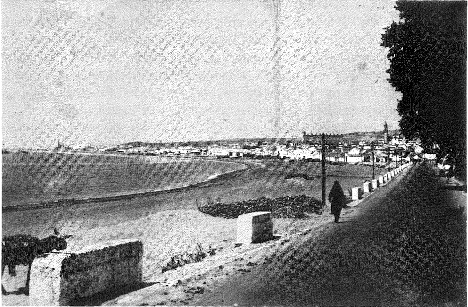
Antigua carretera Cádiz-Málaga.
