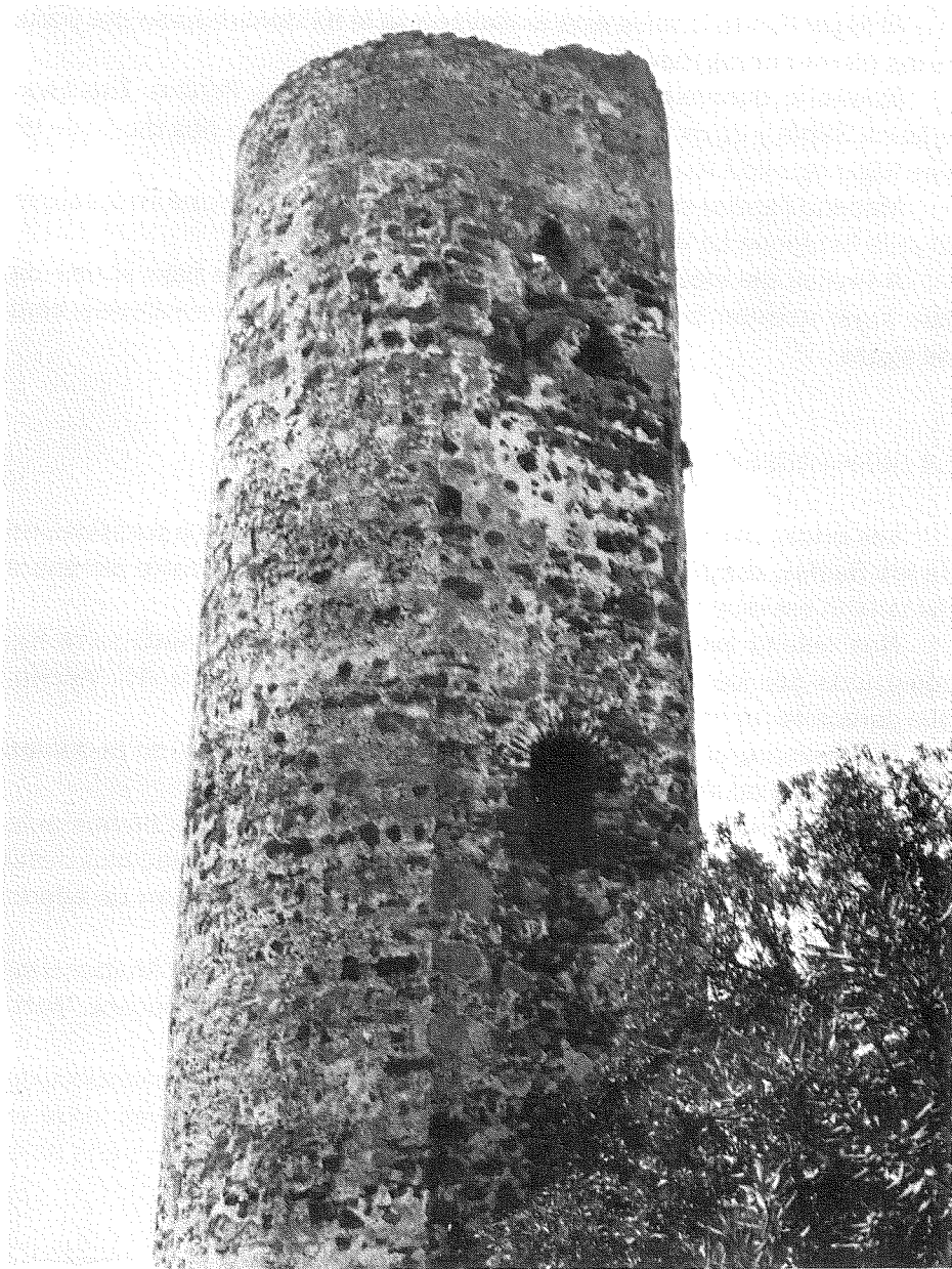
Torre almenara de Baños o de Casasola.
